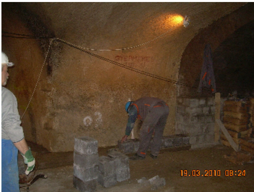
Falazat építése idomkőből
