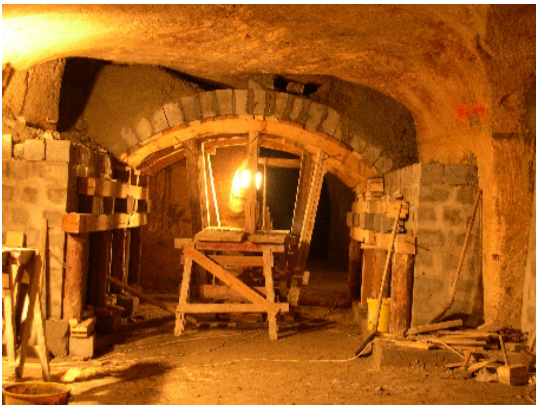
Épülő boltív, felette vállképzés és hézagkitöltés betonból
