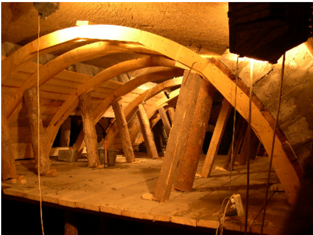
Állásról induló látámasztó ácsolat boltív építéséhez
