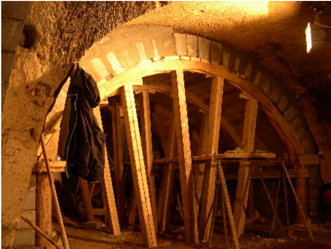
Boltív építése talpról induló ácsolat és mintáiv segítségével
