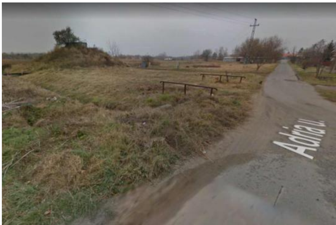
Az Adria utca kitorkolló műtárgy és csatorna
